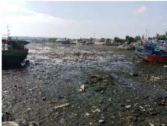
Gambar 1. 1. Pendangkalan Kolam Pelabuhan Akibat Sedimentasi di PPN Brondong Lamongan
