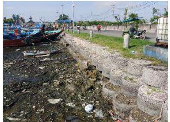
Gambar 1. 1. Pendangkalan Kolam Pelabuhan Akibat Sedimentasi di PPN Brondong Lamongan
