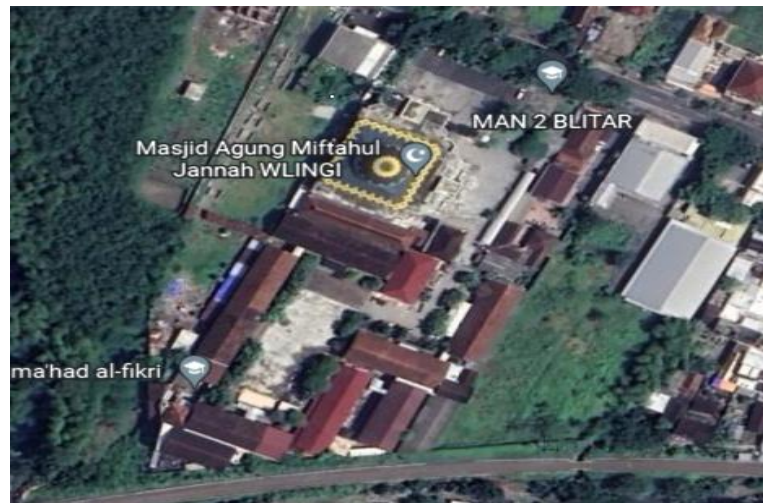
Gambar 3. 1 Penampakan MAN 2 Blitar dari atas yang dilihat dari Google Earth
