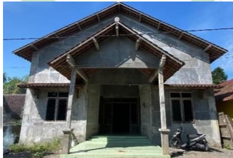
Gambar 5. 10 Gedung Olahraga (GOR)
