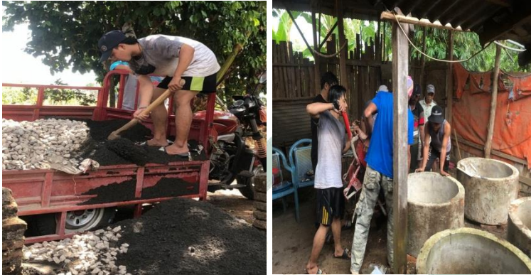
Gambar 7. 5 Proses Mengecor Buis dan Pembuatan Saluran Air
