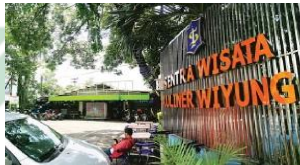
Gambar 4. 1 Tampak depan SWK Wiyung sebelum direnovasi
