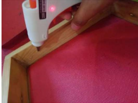
**Gambar 4. 20** Memasang Lapisan Anti Air Pada Bingkai
