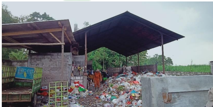
Gambar 4. 5 Bangunan TPST Desa Kepatihan
