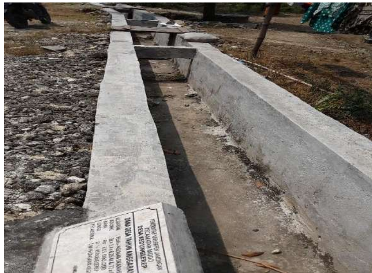
Gambar IV. 7 Drainase Desa Kedunglerep di Dusun Bajul
