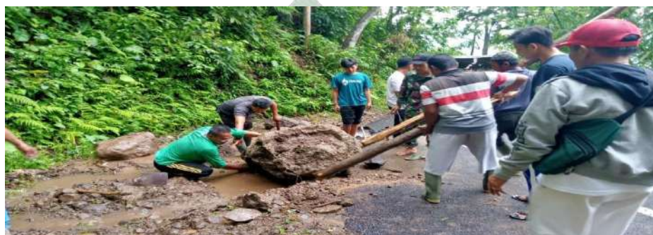
Gambar 4.17 Pembersihan akses jalan.
