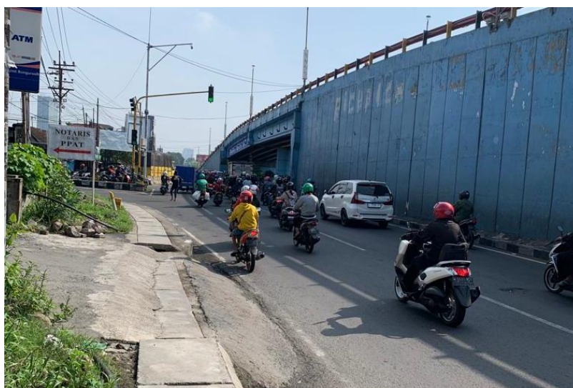
Gambar 4. 2 Kondisi Lapangan Titik 1
