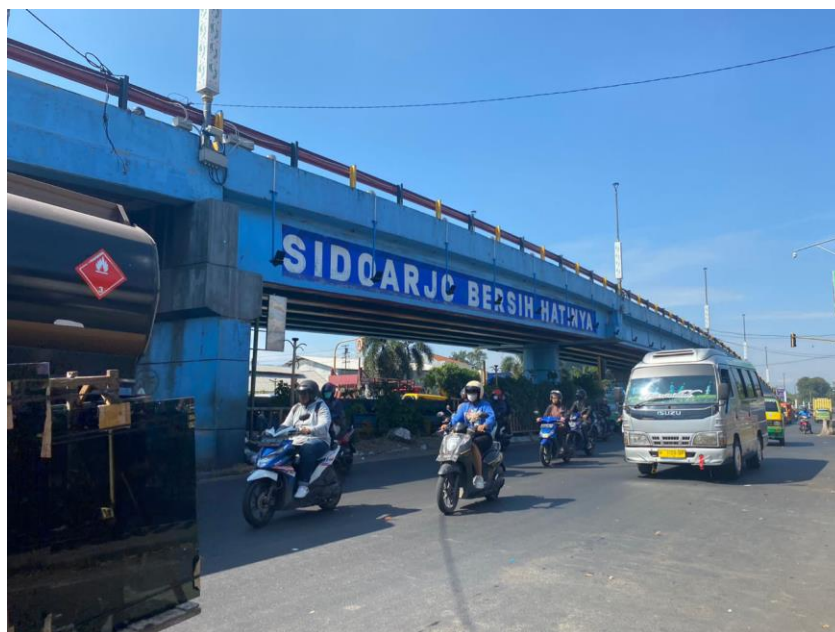
Gambar 4. 5 Kondisi Lapangan Titik 4
