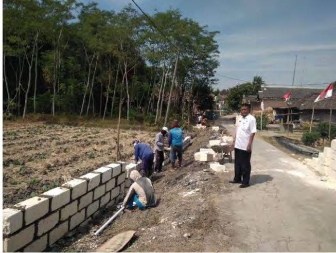
Gambar 4.2 Pembangunan Plengseng atau Pembatas Jalan
