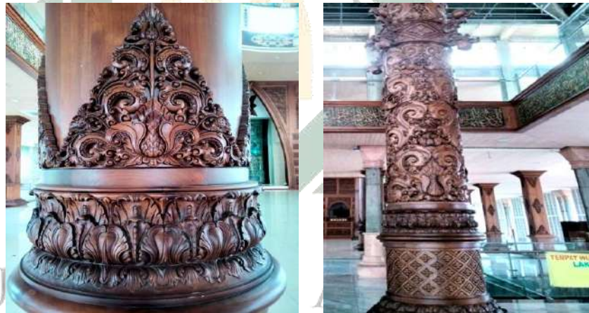
Gambar 4. 25 Tiang Penyangga di ruang utama (kiri) dan di ruang serambi (kanan) (Sumber : Dokumentasi Pribadi pada 28/9/22)
