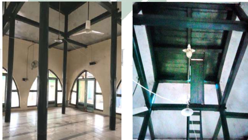
Gambar 4. 4 Soko guru pada masjid lama dan bagian atap sebagai tempat muadzin (Sumber : Dokumentasi Pribadi pada 28/9/22)
