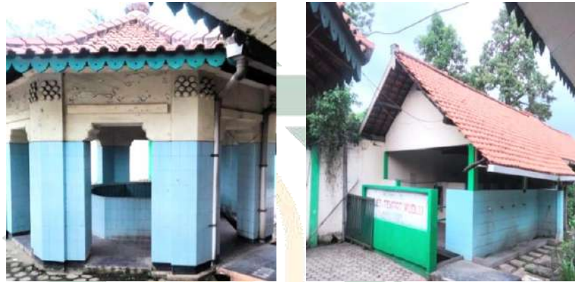
Gambar 4. 8 Tempat Wudhu segi delapan pada Masjid lama Darussalam (kiri) dan penambahan tempat wudhu (kanan) (Sumber : Dokumentasi Pribadi pada 28/9/22)
