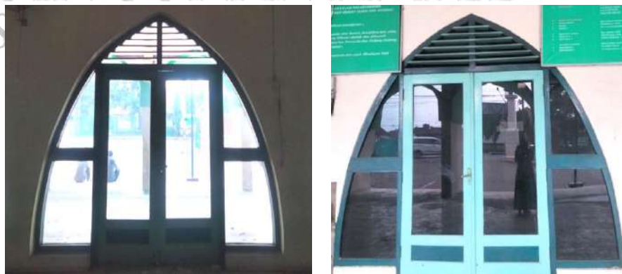
Gambar 4. 5 Pintu Masjid lama Darussalam tampak dari dalam dan dari luar (Sumber : Dokumentasi Pribadi pada 28/9/22)
