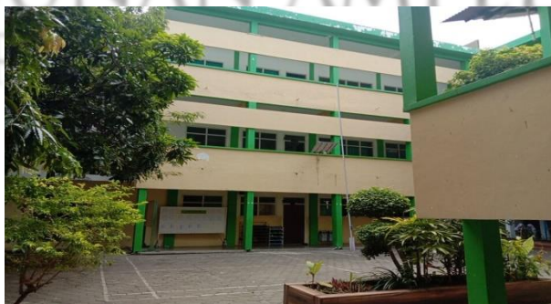
Gambar 4. 2. Gedung Madrasah Tsanawiyah Putri YKUI Maskumambang
