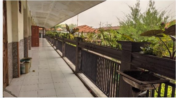
Kran air dan tanaman di setiap depan kelas
