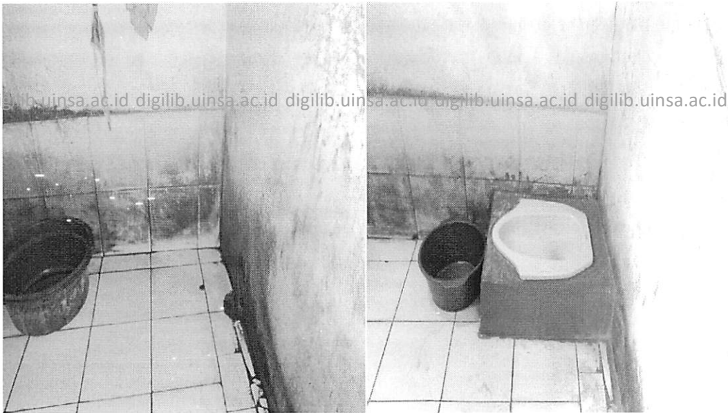
Gambar 8: Sebelum dan sesudah pembangunan WC Pribadi hasil dari Arisan Jamban Sehat
